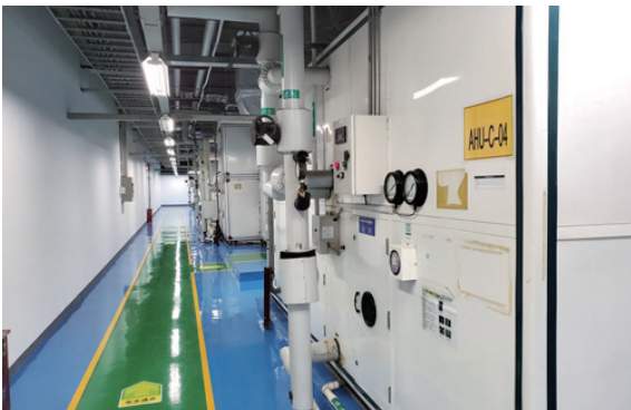
▲索尼数字产品（无锡）有限公司运用 IoT 技术，在洁净室负荷较低的状况下，系统自动识别并调整组合式空调机的运转频率，实现年节约能源 490,000kwh
